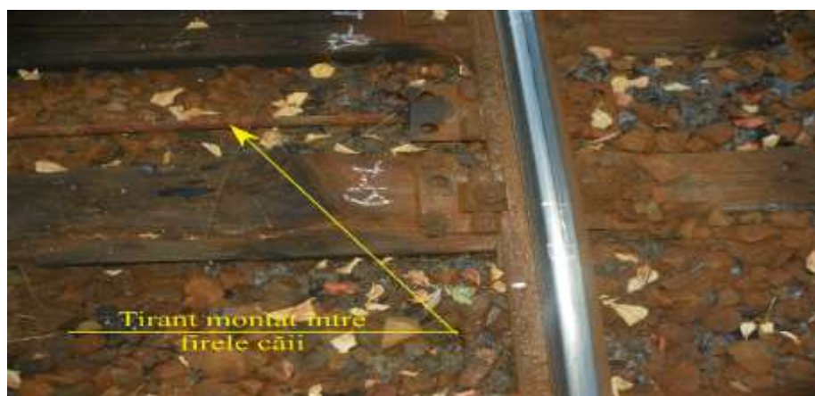
Foto.nr.7 - Tirant montat între firele căii
