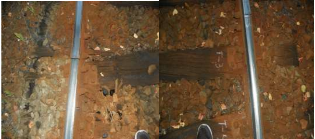
Foto.nr.10 - Traversa T-3
