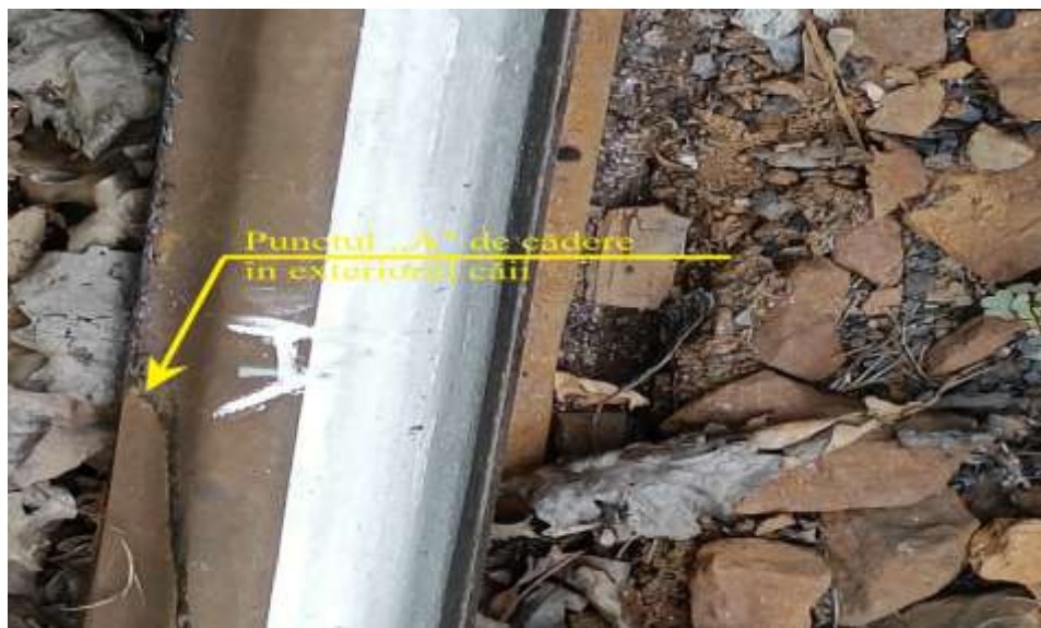
Foto nr.4: Punctul „A” – prima urmă de cădere în exteriorul căii (roata din partea stângă a osiei nr.6, în sensul de mers)
