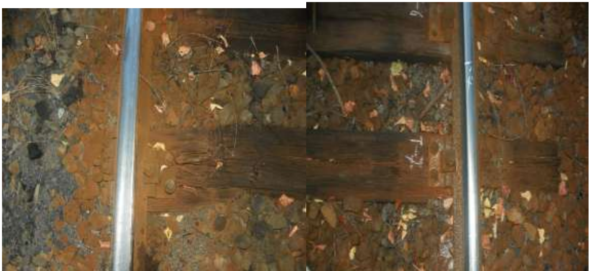
Foto.nr.11 - Traversa T-7
