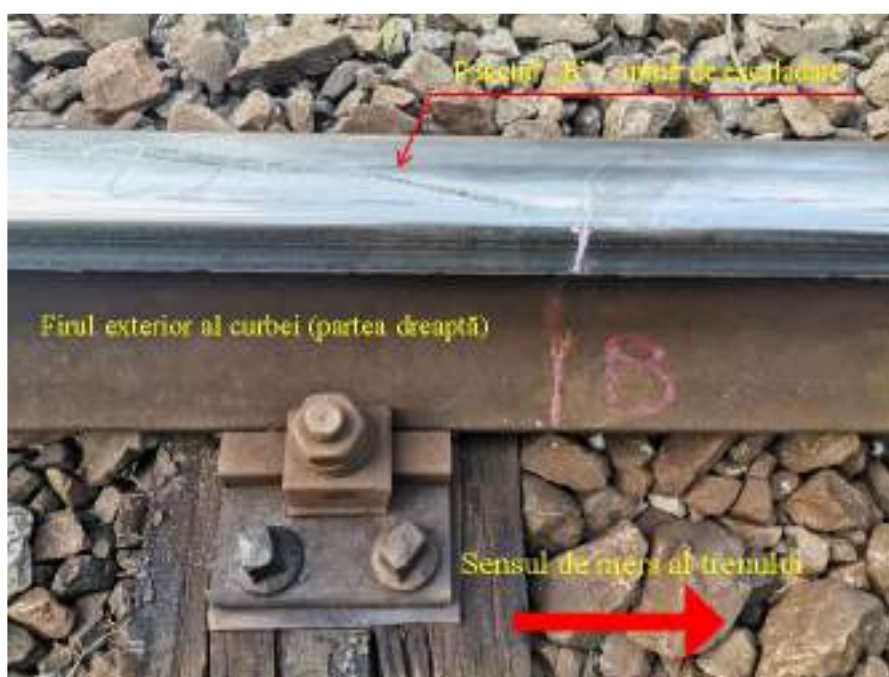
Foto. nr.3 – Punctul „B”: urmă de escaladare pe firul exterior al curbei
