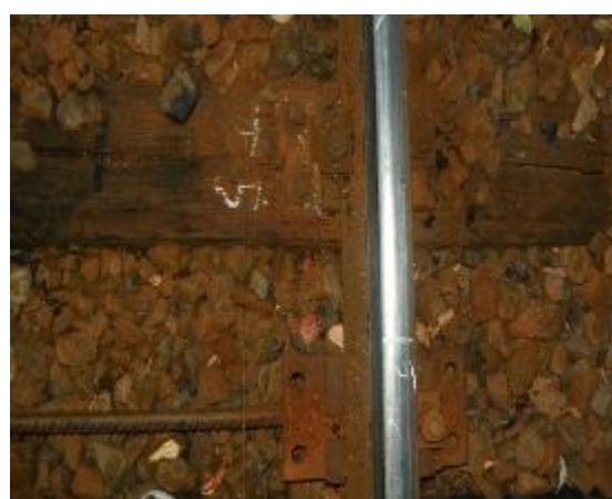
Foto.nr.6 - Traversa T 5
