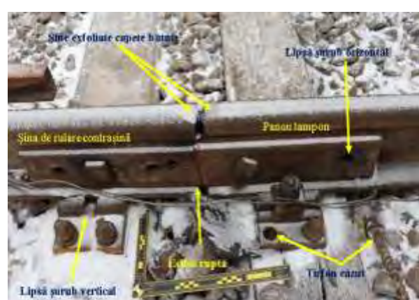
Foto nr.32 – Joanta după contrașină fir stâng ext.
