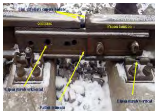
Foto nr.31 – Joanta vârf schimbător fir stâng int.
