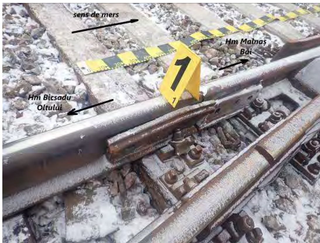
Foto nr.5 – Joanta capăt schimbător nr.1R cu eclisa metalică exterioară
