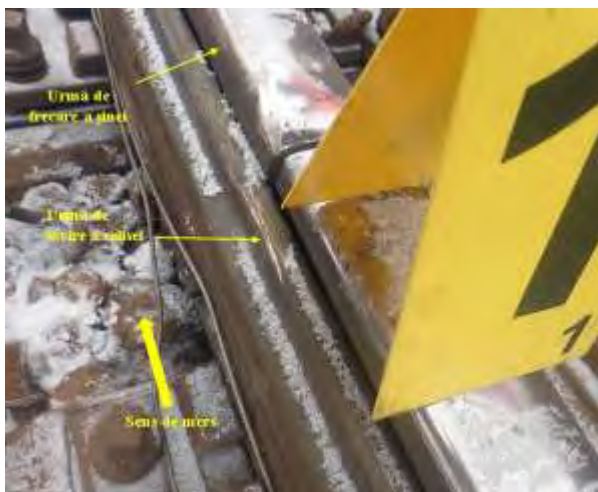
Foto nr. 13 – Eclisă lovită, urmă de frecare a șinei Foto nr.14 – Urmă de frecare a șinei
