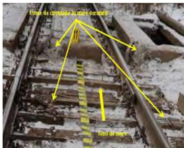
Foto nr.26 – Urme ale circulației în stare deraiată
