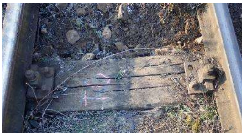
Foto nr.2 Traversa T0
