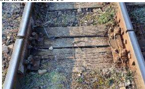
Foto nr.4 Traversesele T-2 și T-3
