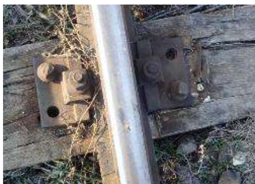
Foto nr.3 Traversa T-1
