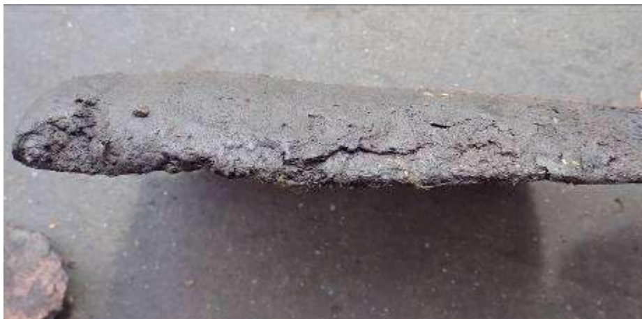
Foto nr.6 – detaliu material izolație termică
