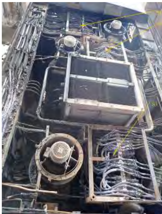
Foto nr.4 Blocurile S1, S2 și S3 – vedere de sus cu acoperișul locomotivei demontat
