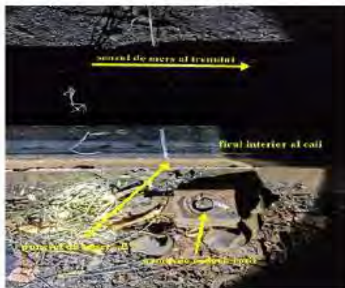
Foto nr.6: Punctul „E” – urma de cădere la interiorul căii a roții din partea stângă a osiei nr.2, în sensul de mers
