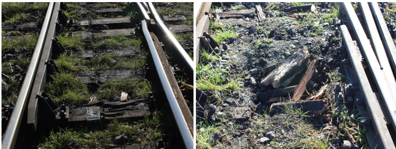
Foto 2,3,4,5: pagube produse la suprastructura căii
