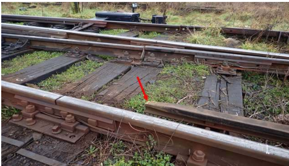
foto nr.11: zona punctului 0
