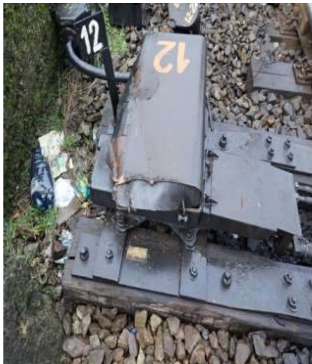
foto nr.4, 5: afectarea suprastructurii căii de către vagoanele deraiate
