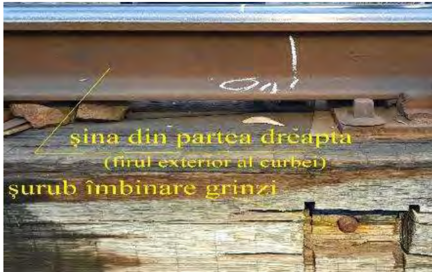
Imaginea nr.17 - îmbinarea grinzilor de lemn care susțin firul exterior al curbei
