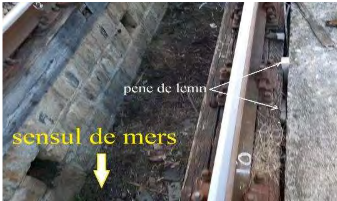
Imaginea nr.16 - pachetul de grinzi nr.3 (șina firului interior a curbei)
