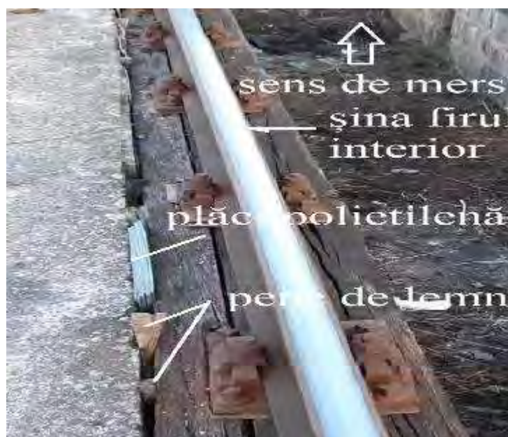
Imaginea nr.20 - montarea penelor de lemn
