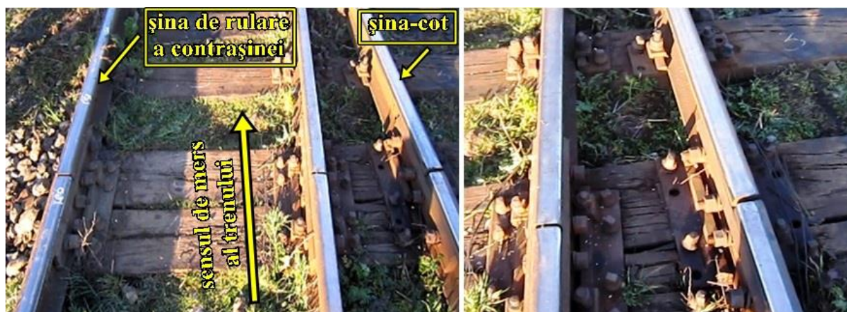
foto nr.8 - direcția „abatere” traversele din zona joantei de vârf a inimii
