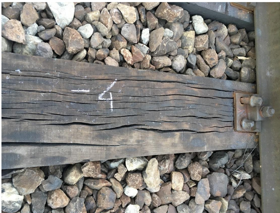
Traversa nr. „-4”, firul interior al curbei – crăpături longitudinale, prinderi inactive
