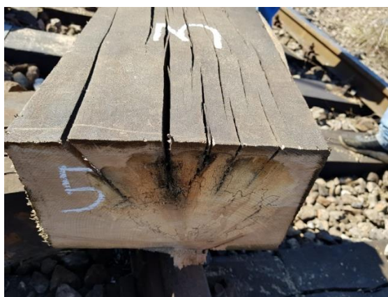
secțiunea nr.3 - inimă roșie, crăpături dinspre fața superioară spre interior, formare secțiuni de rupere
