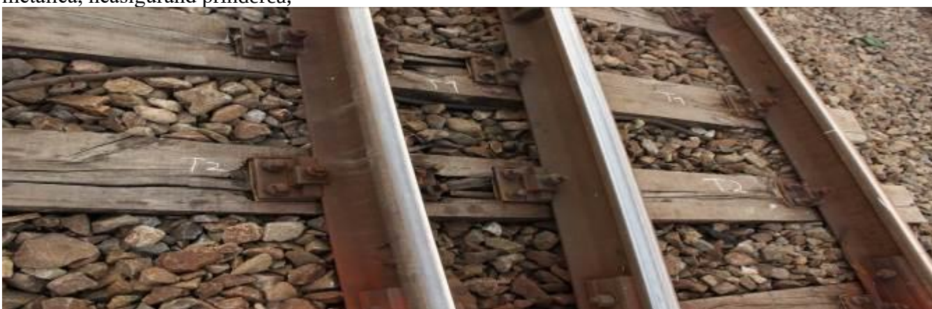
foto nr.10: traversa T_2
