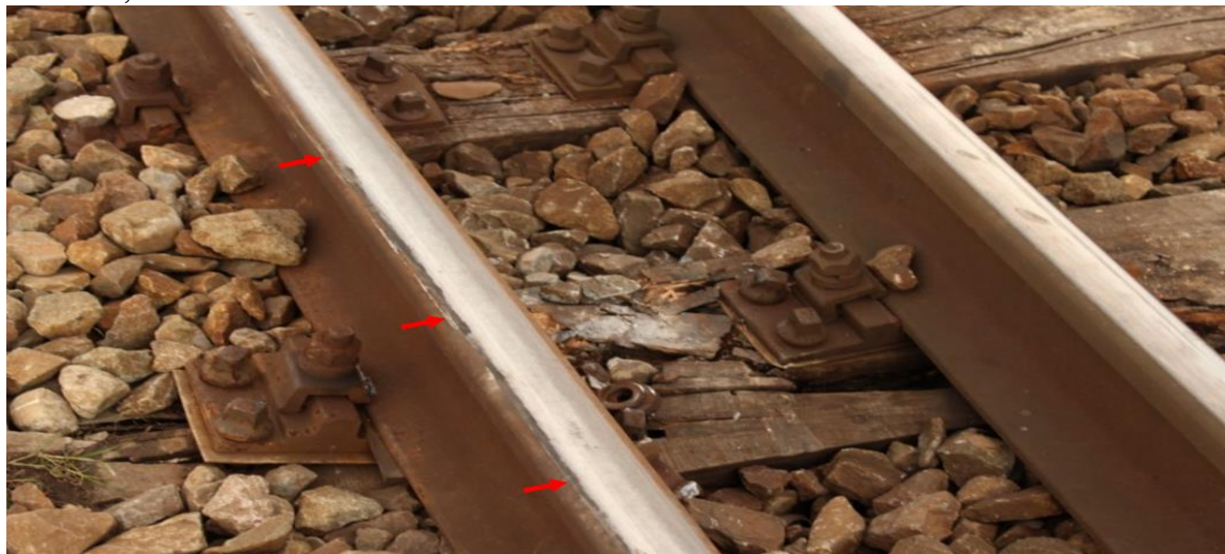
foto nr.4: locul părăsirii suprafeței de rulare de către roțile din partea stângă
