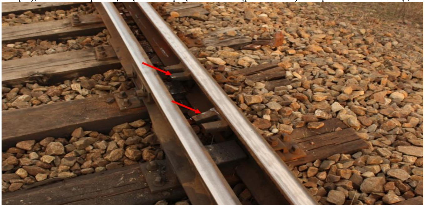
foto nr.7 : zonele de lovire și escaladare a proțapilor de către roțile deraiate
