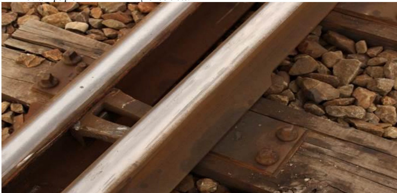
foto nr.1: zona în care vagoanele au escaladat pe proțapi
