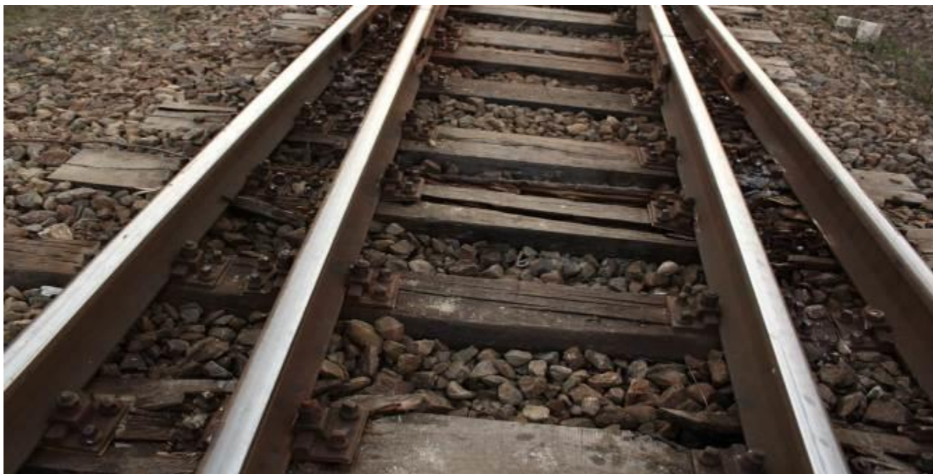
foto nr.12: prisma de piatră spartă în zona punctului 0
