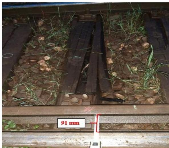
*Foto. nr.6 în dreptul traversei T<sub>1</sub> valoarea măsurată a intervalului liber dintre fața laterală vecine ale ciupercii șinei de la firul interior al căii și contrașină*
