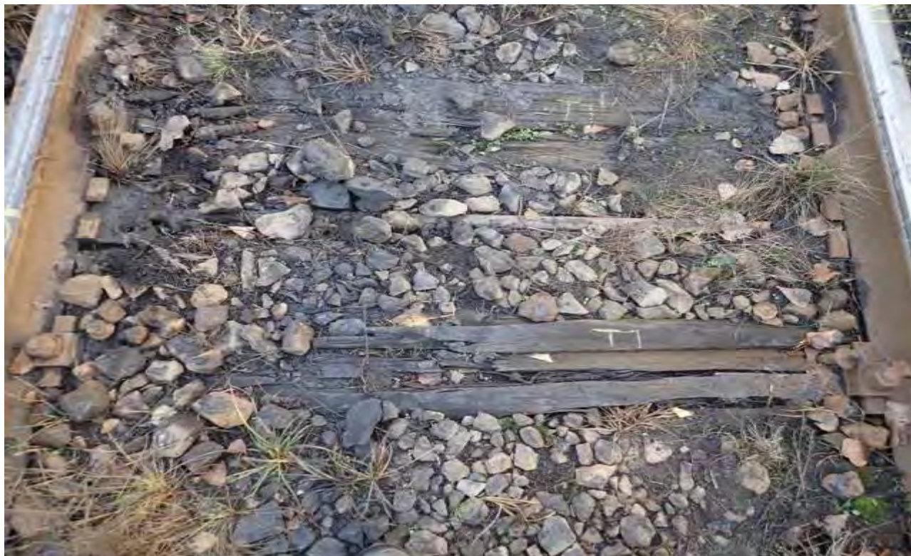
foto nr.5: traversele T 1 și T 1 '
