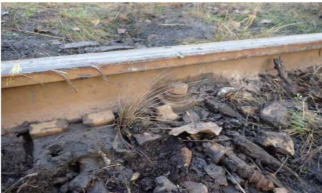
foto nr.2: urmele create pe suprafața activă a șinei de roata deraiată din partea stângă
