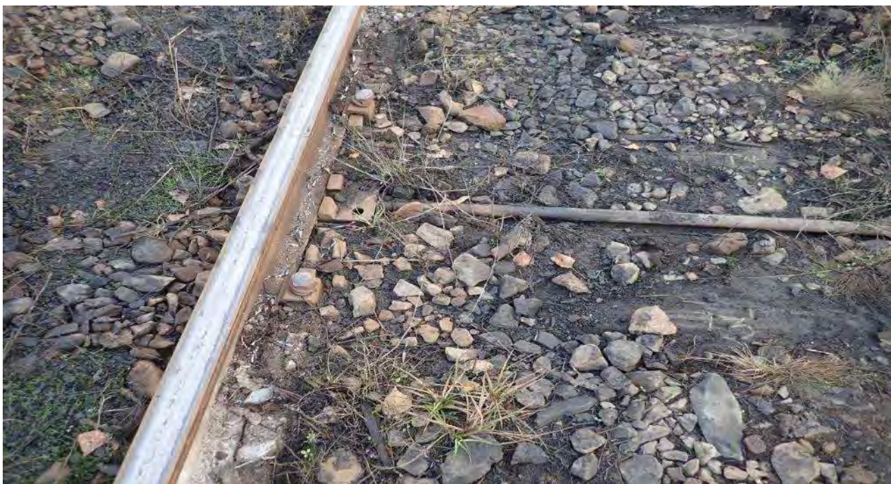
foto nr.9: dispozitiv de menținere a ecartamentului în toleranțe (tirant)
