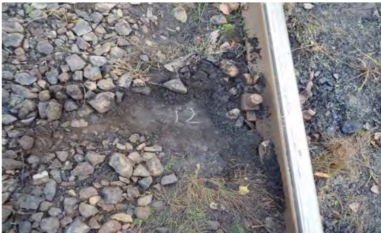
foto nr.6: traversa T 2 pe firul interior al curbei
