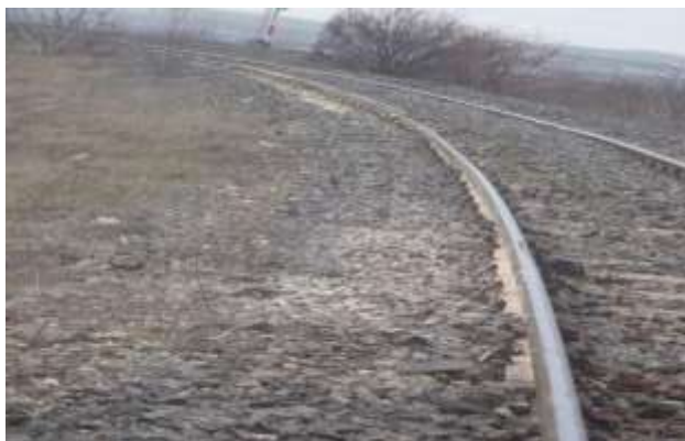
Foto nr.11 Prisma de balast colmatată cu material pulverulent
