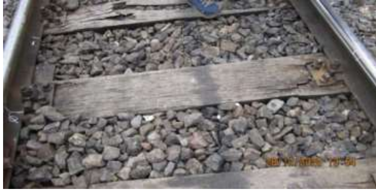
Foto nr.4 Prima urma de lovire a bulonului vertical
