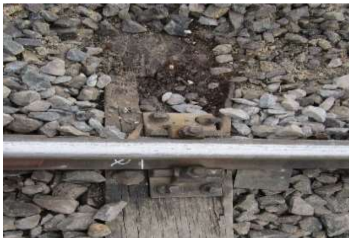
Foto nr.9 Starea traversei T 1
