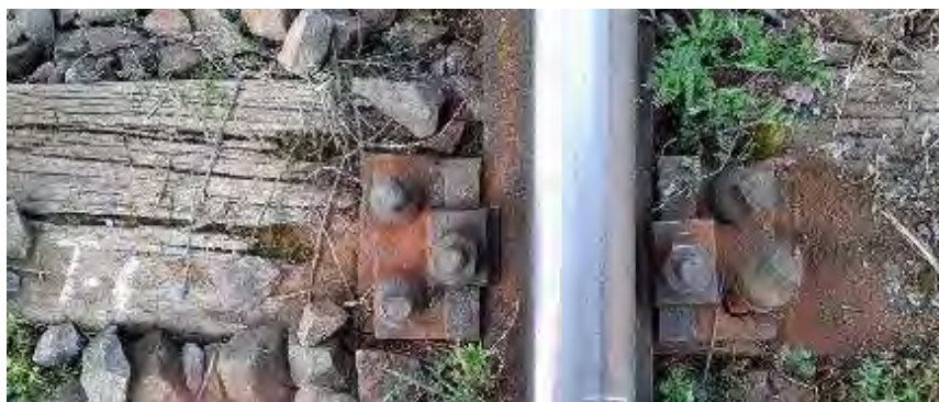
Foto. nr.5 - Traversa nr.T-1
