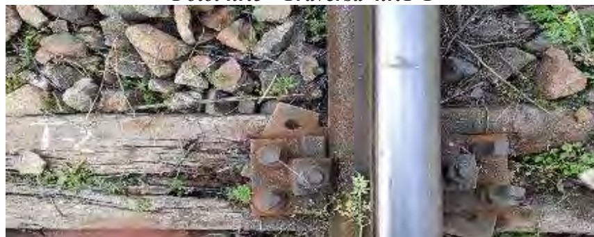
Foto. nr.6 - Traversa nr.T-2
