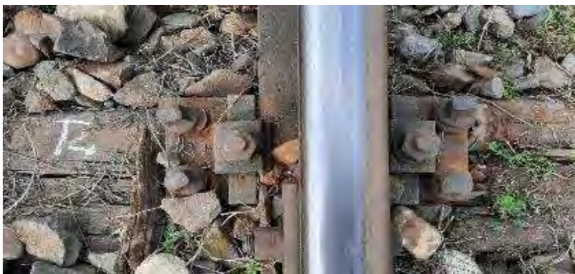
Foto. nr.4 - Traversa nr.T4
