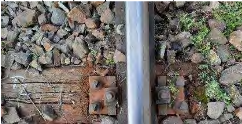
Foto. nr.3 - Traversa nr.T2
