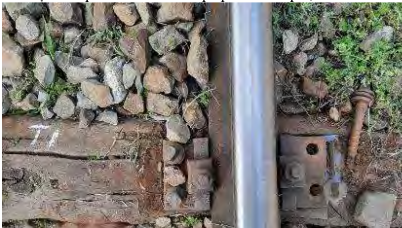
Foto. nr.2 - Traversa nr.T1
