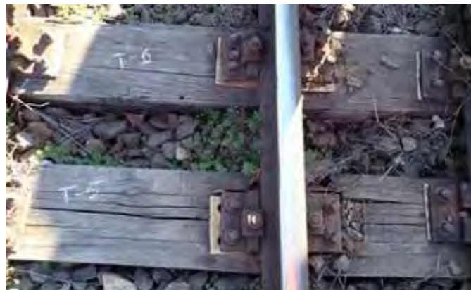
Foto nr.9 - traversele T-5 și T-6
