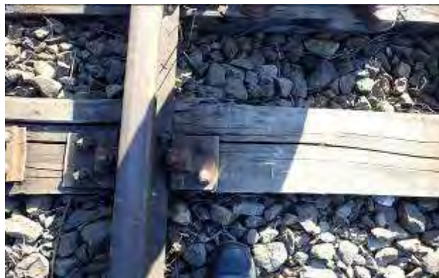
Foto nr.5 - traversa T_1
