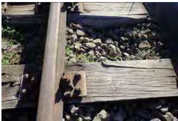
Foto nr.8 - traversele T-3 și T-4
