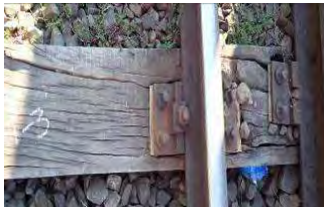
Foto nr.7 - traversa T_3
