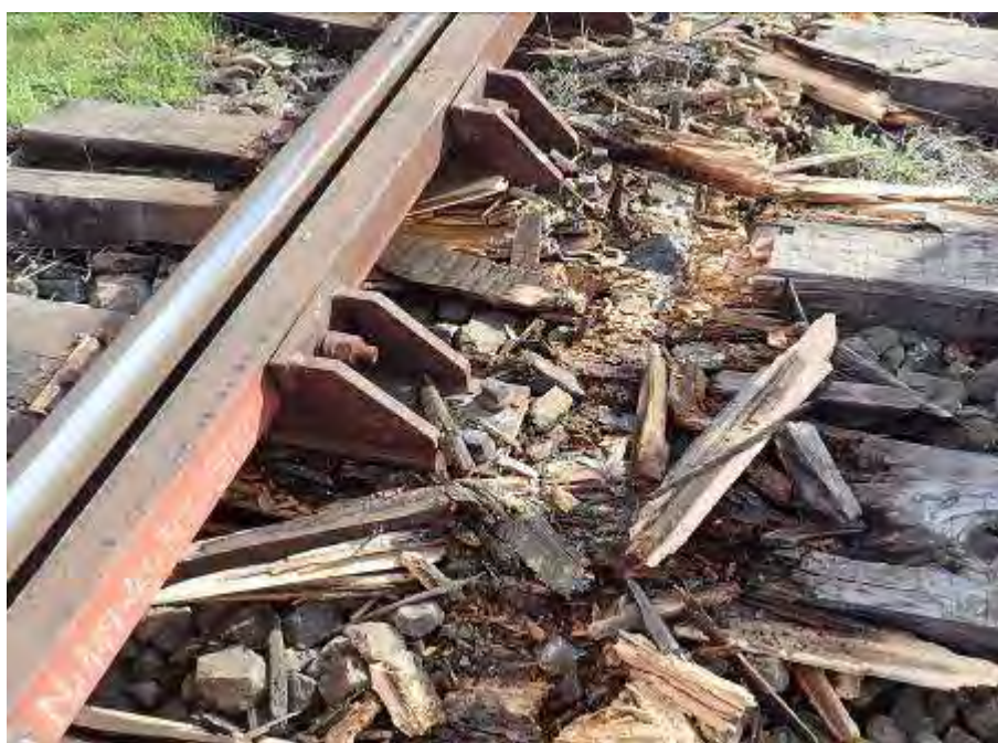
Foto nr.10 – traverse putrede la interior, sfărâmate în urma deraierii
