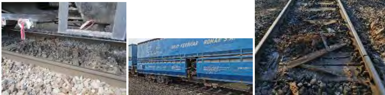
Foto nr.6, traverse rupte de vagoane pe zona deraiată
