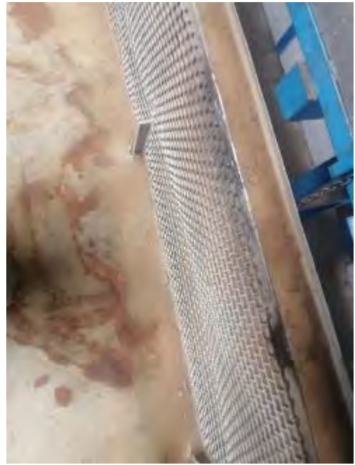
Foto nr. 2 - urme de arc electric pe grilajul de protecție din dreptul disjuncteurului
