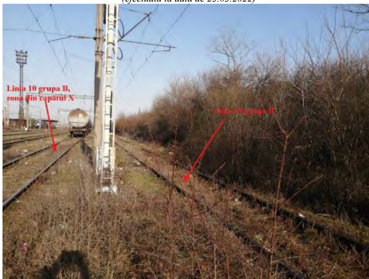
Foto nr. 10 - zona din capătul X al stației Ploiești Est - liniile 10 și 11 din grupa B (efectuată la data de 23.03.2022)
