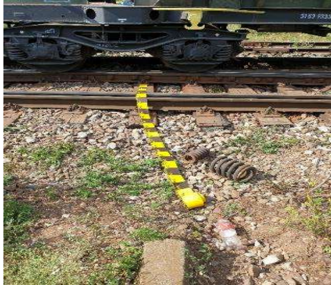
FOTO nr. 6, distanța de la linia de circulație până la setul de arcuri elicoidale de suspenție, sărite de la al doilea boghiu al primului vagon deraiat.
