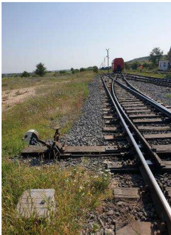
Foto nr.2 - punctul de racord la LFI la infrastructura feroviară publică (km 0+000 al LFI)
