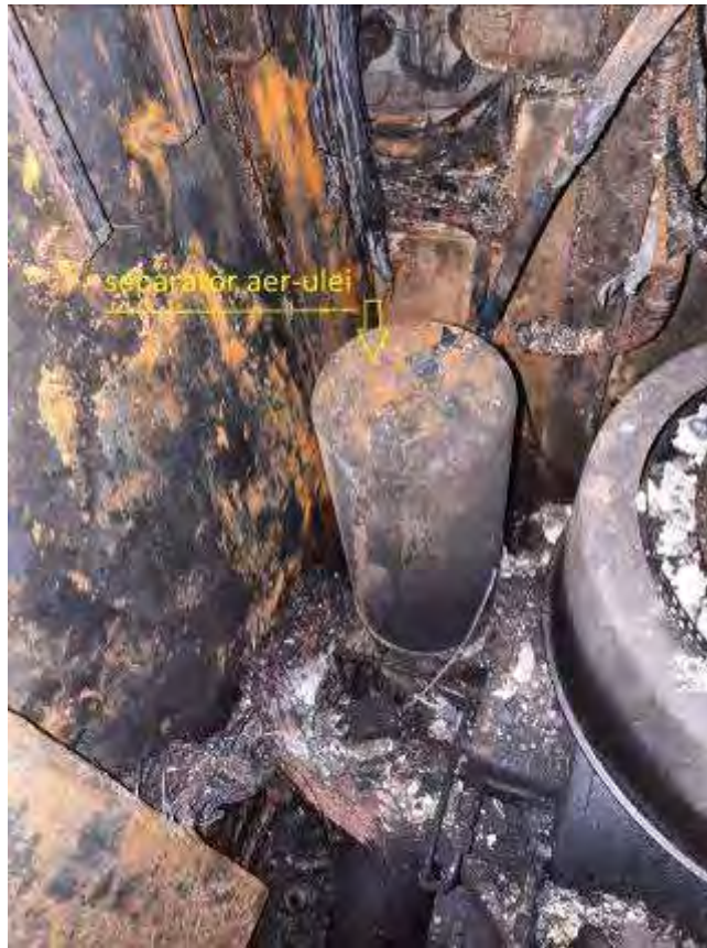
Foto nr.4 - separator aer - ulei
