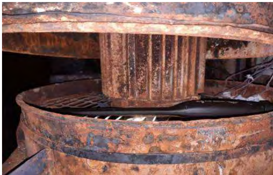
Foto nr.3 – electromotorul răcitorului de ulei
