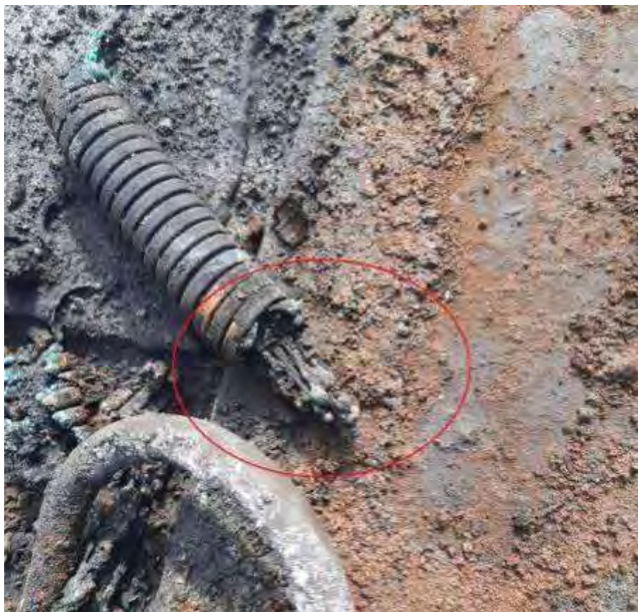
Foto nr.16 - Bucata de cablu căzută pe boghiul I cu efectele arcului electric
