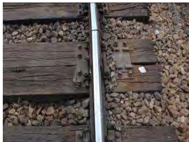
Foto nr.3- joanta de pe firul interior al curbei Foto nr.4 - joanta de pe firul exterior al curbei
