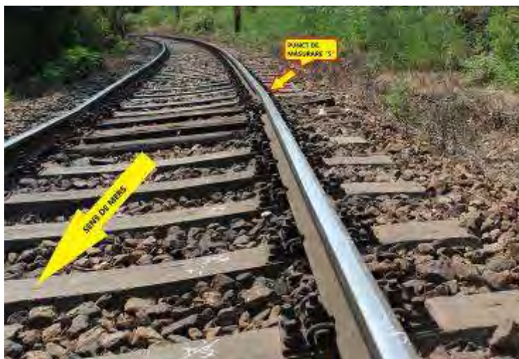
Foto nr.2 – direcția căii în punctul de măsurare „5”
