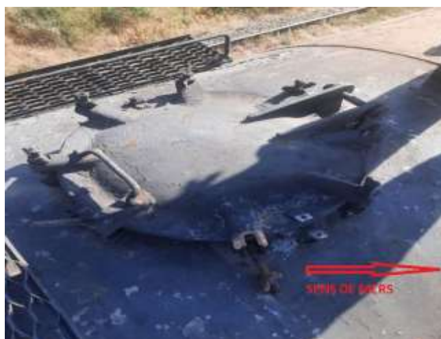
Foto nr. 4 - urme de afectare termică în zona domei de încărcare și șurubul căzut din urechea de fixare
