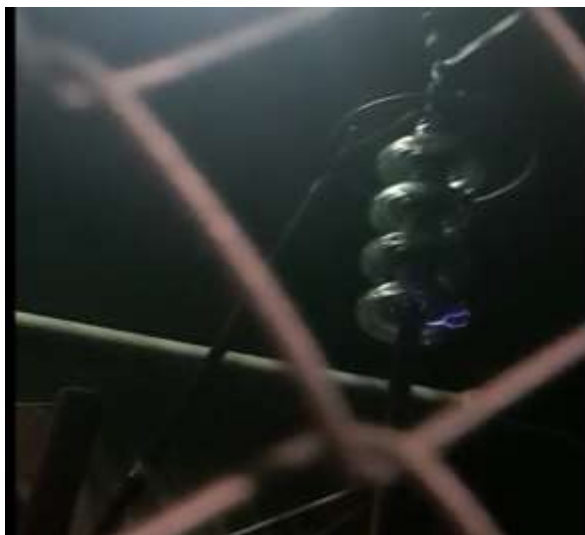
Foto nr. 13 - apariția descărcărilor electrice locale
