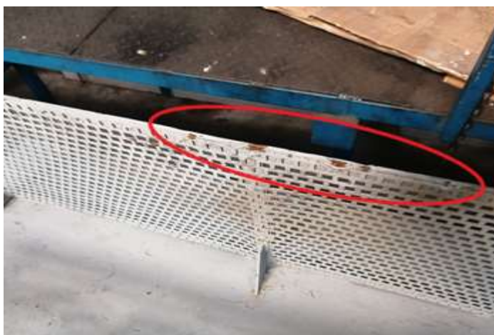
Foto nr. 1 - 5 puncte de arc electric la partea superioară a apărătorii din partea stângă a locomotivei
