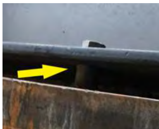
Imaginea nr.9 – capătul rezervorului era lăsat în jos 2,5 cm deoarece prinderea era ruptă
