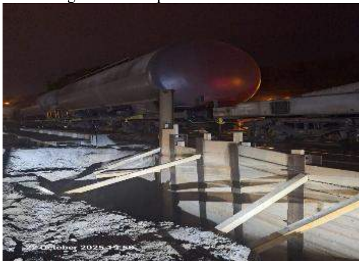
Imaginea nr.6– Imagine cu profile H 240 montate
