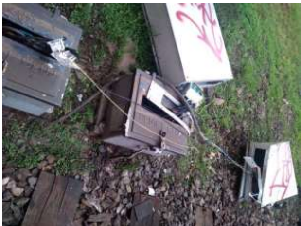
Fotografii cu pagubele produse la încălzitoarele de macaz
