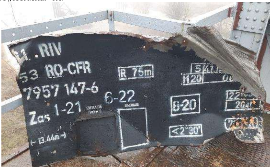
Foto nr.4 – tabla indicatoare recuperată pe podul feroviar la km 343+593
