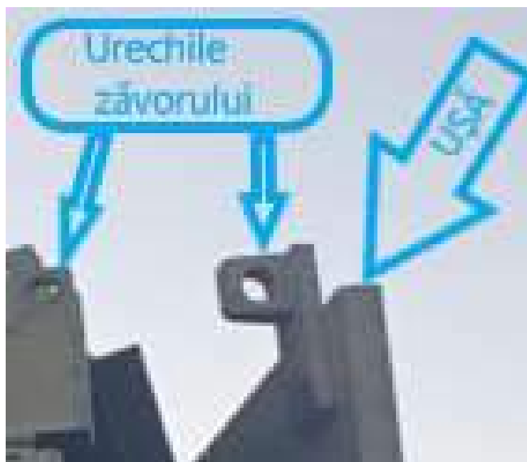
Imaginea 5 – ușă de vizitare deschisă și axul de înzăvorâre lipsă
