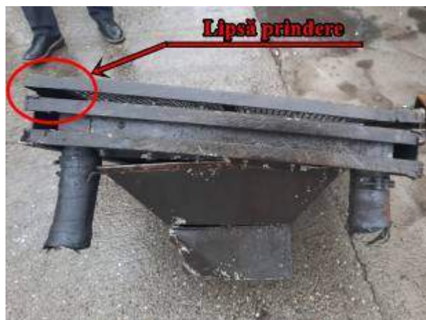
Foto nr.7 Locul corespondent fără prindere
