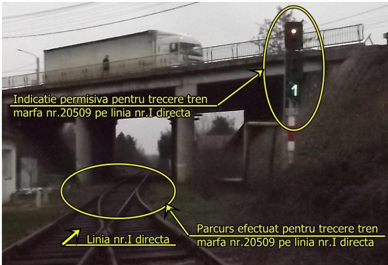
Foto nr.1 Poziția acelor macazului schimbătorului de cale nr.2
