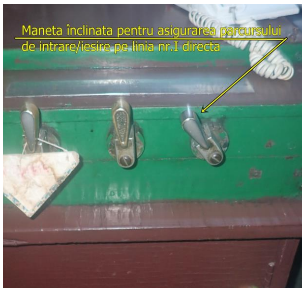
Foto nr.3 Cutia mecanică a blocului SBW din biroul de mișcare
