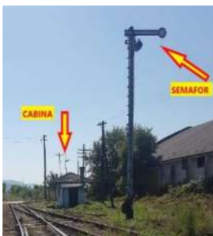
imaginea nr.4 – semaforul de ieșire (fotografie pe timp de zi)
