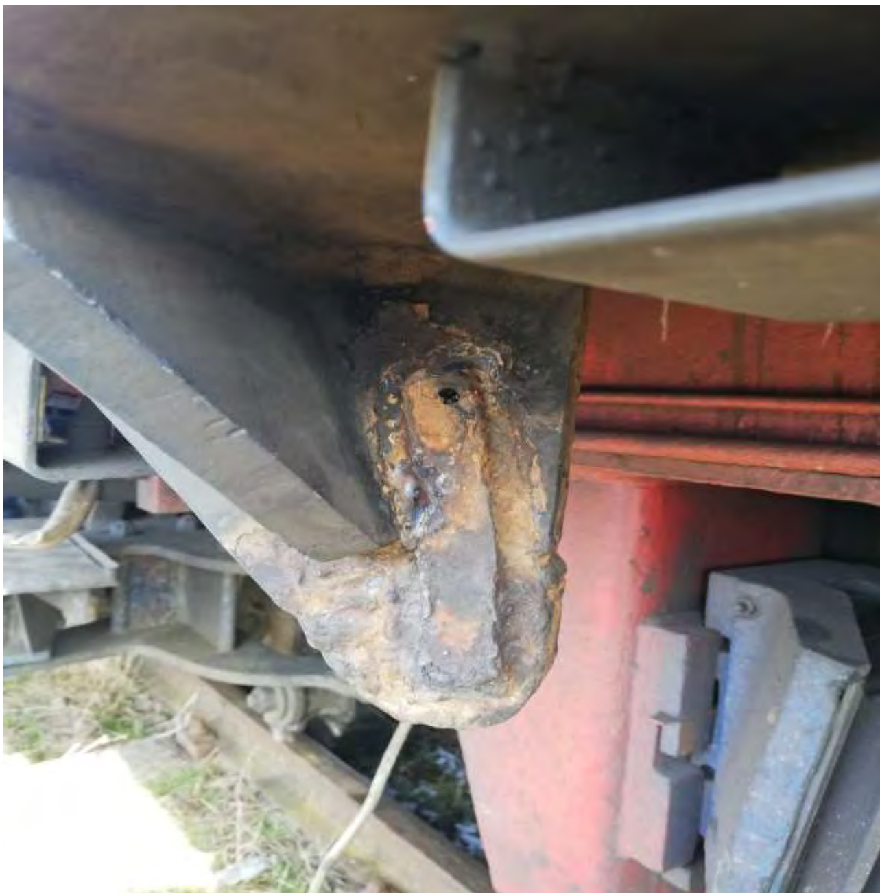
Foto nr.6 – Modul de aplicare prin sudură a unei plăci de consolidare pe partea exterioră (vizibilă) a suportului de fixarea urechii superioare a amortizorului
