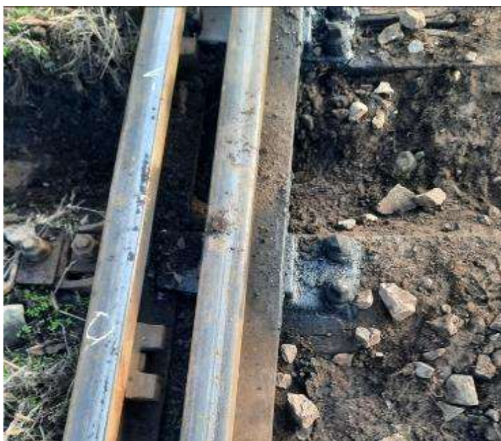
Imaginea nr.8 - traversele acoperite de pământ și cărbune
