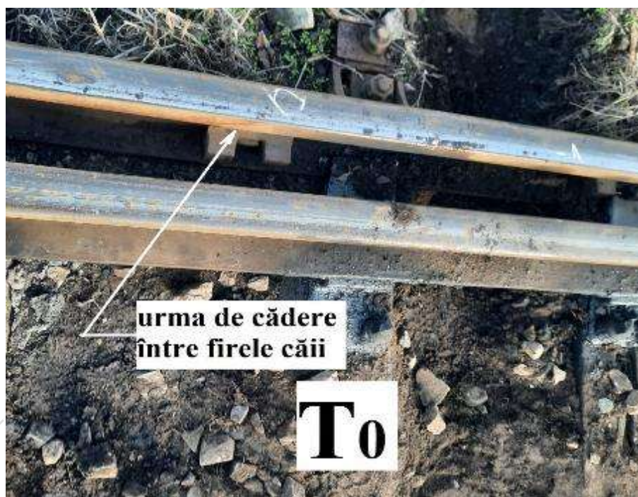
Imaginea nr. 6 - punctul „0” prima urmă de cădere între firele căii
